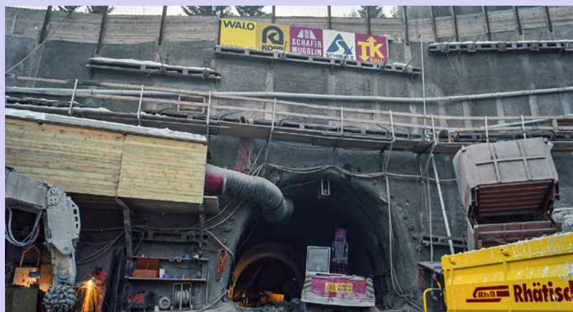
Bauarbeiten für den Autoverlad durch den Vereinatunnel in Klosters Selfranga 1991. Bild: Fotostiftung Graubünden
