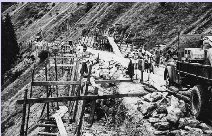
Teilneubau und Verbreiterung der Lukmanierstrasse (1950–1972).
