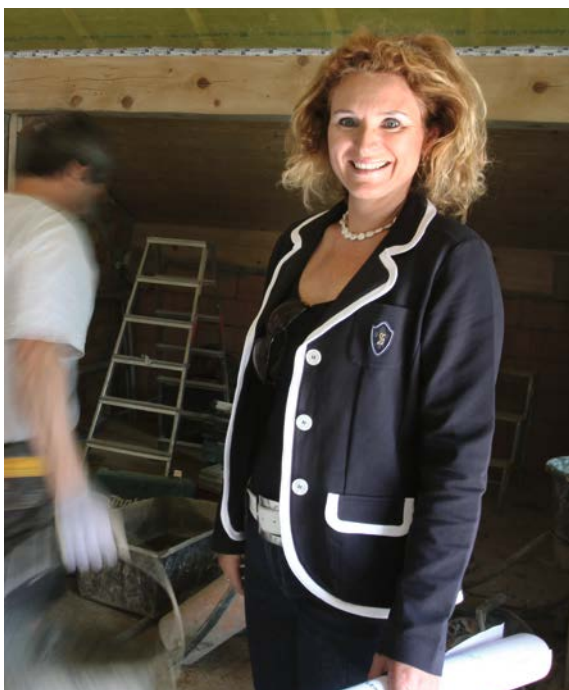
Ina Good auf einer Baustelle einer Wohnung, die sie aktuell im Engadin umbaut.
