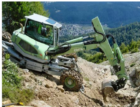
Schreitbagger bei der Arbeit in unwegsamem Gelände.
