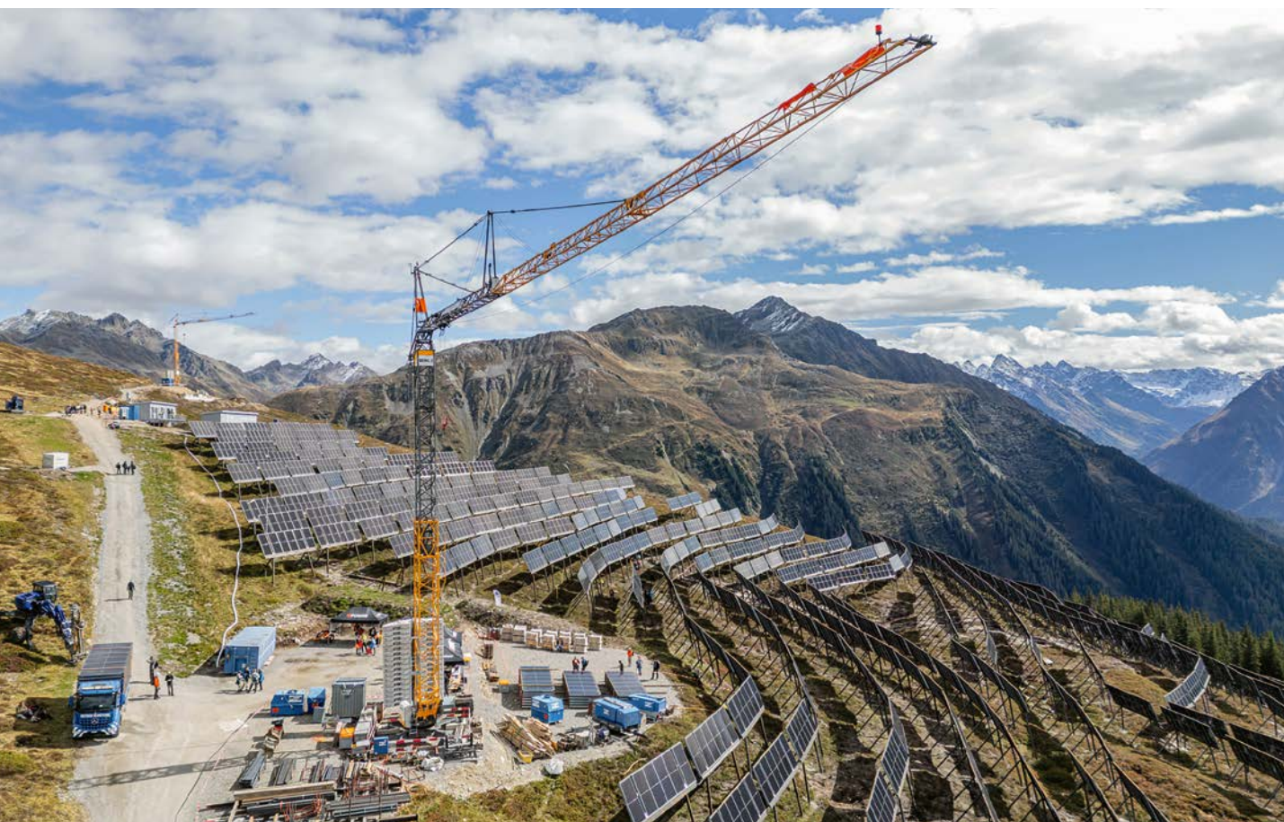
Bauarbeiten an der Solaranlage Madrisa Solar.
