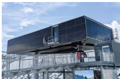
PV-Anlagen an der Fassade eines Stalls und der Bergstation Cassons.
