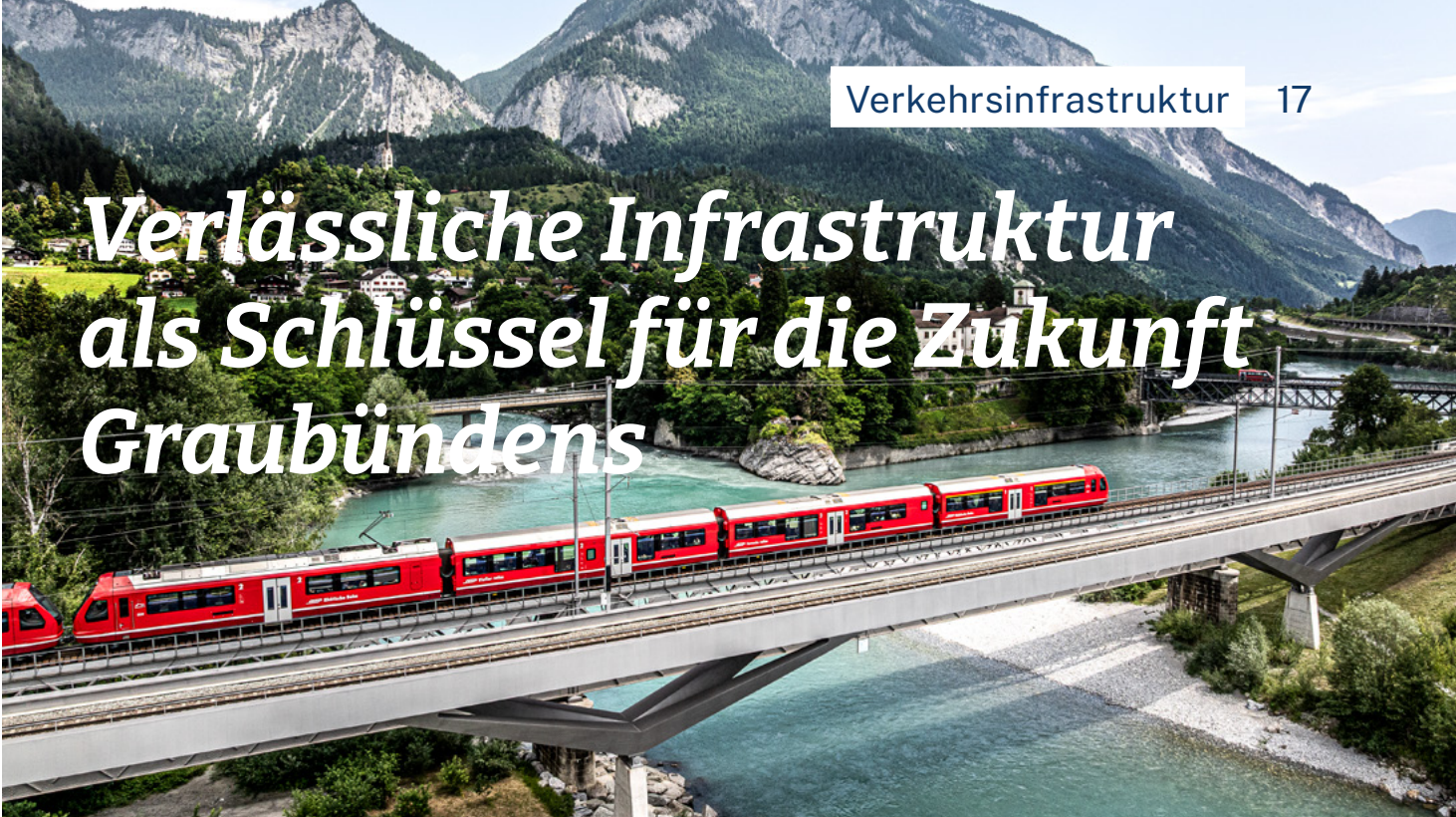
Regiozug auf der Hinterrheinbrücke.
