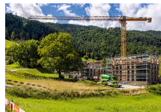
Ein Mehrfamilienhaus ist am Entstehen.
