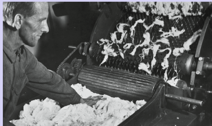
Tuchfabrik Truns, Trun (Eröffnung 1912).
