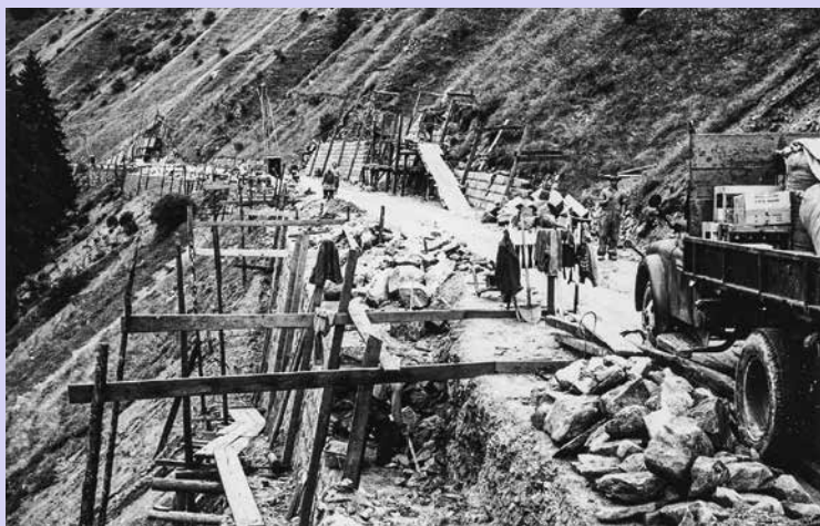
Teilneubau und Verbreiterung der Lukmanierstrasse (1950–1972).
