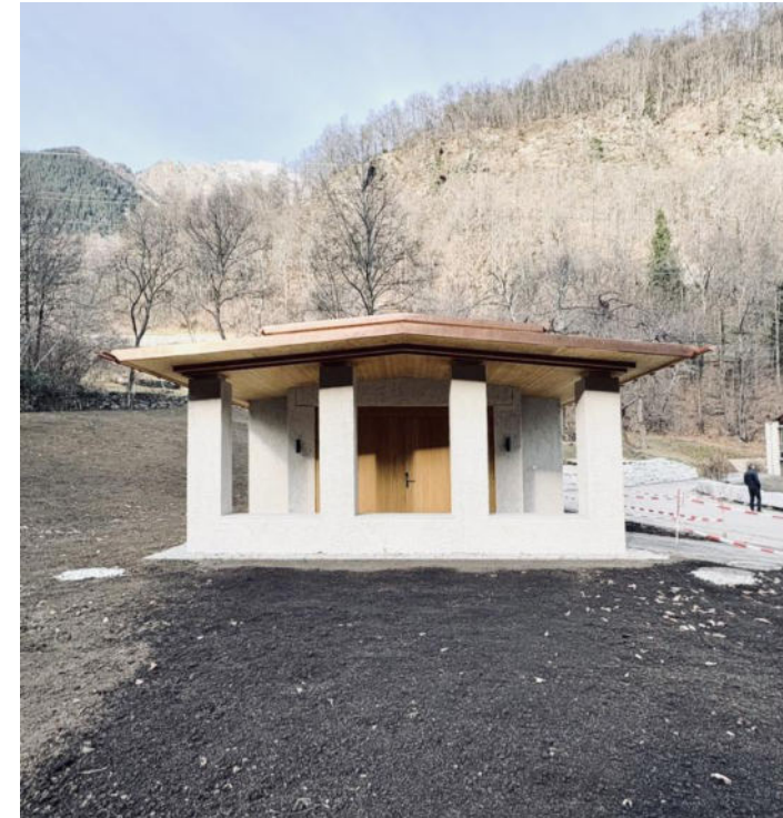
Abdankungskapelle Centro Sanitario Bregaglia
